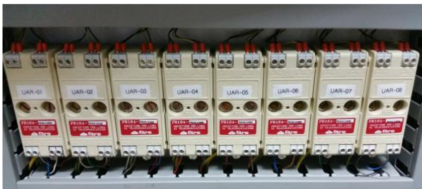
Figura 11 – Protección contra sobretensiones del CDA.
