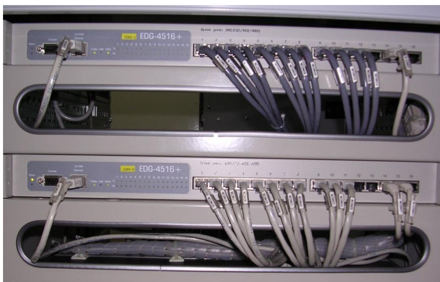
Figura 13 - Convertidor EDG-4516+, RS232/Ethernet.
