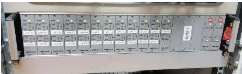
Figura 12 – Rack com os modems RS232 da CDA.
